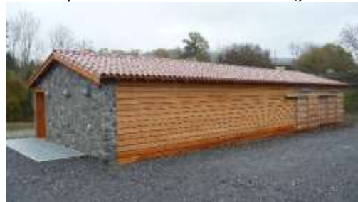
Photo panneau de valorisation du site (fin du chantier en nov 2015)
