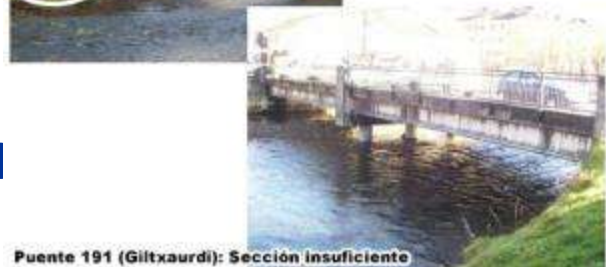
Puente 191 (Giltxaurdi): Sección insuficiente
