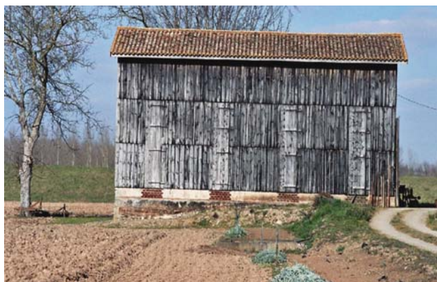
Séchoirs à tabac - à gauche : bardage bois ; à droite : murs de briques, volets bois à claies réglables
