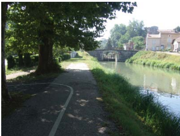
Pont-écluse de Caumont (sur Canal)
