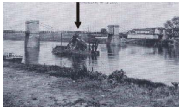
Drague mécanique à Tonneins
