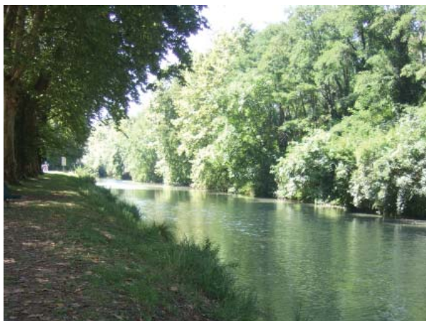
Propriété entièrement enclose par une digue.
