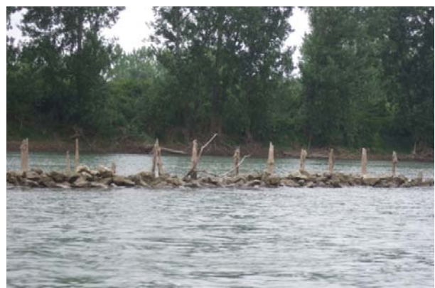
Pieux servant à fixer les ouvrages de protection des berges
