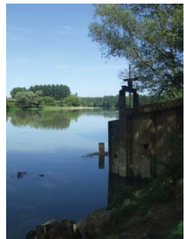
Vanne de Lagrère
