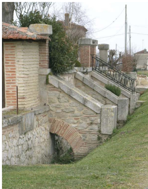
Maison à étage avec escaliers-ponts en maçonnerie de pierre et de briques, vers Sarraliers
