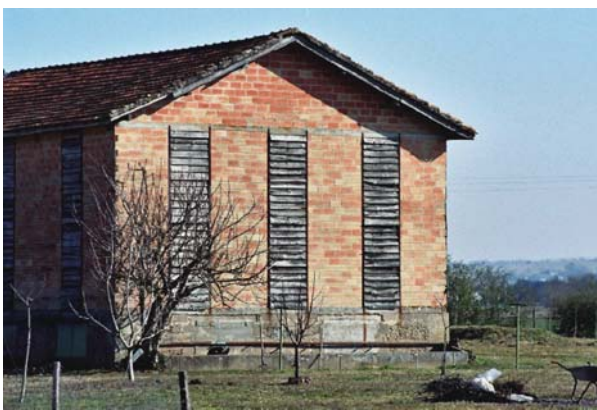
Séchoirs à tabac - à gauche : bardage bois ; à droite : murs de briques, volets bois à claies réglables
