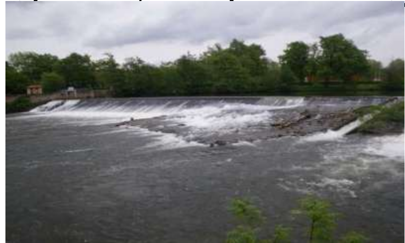
Barrage du ramier - Auterive
