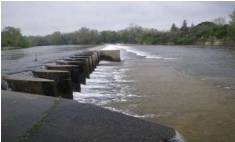
Barrage de la ville - Auterive
