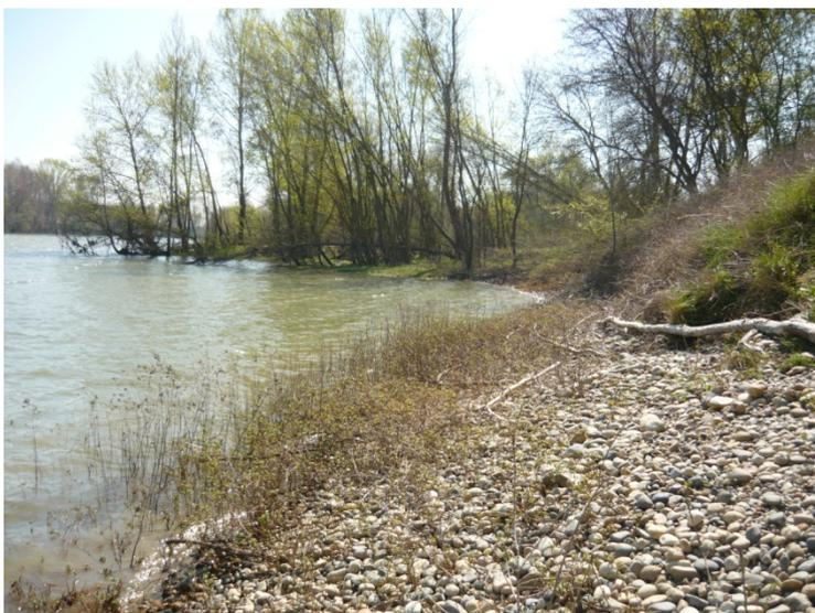
*Dépôt de galets en pied de berge érodée en aval d'un épi submersible en crue*
