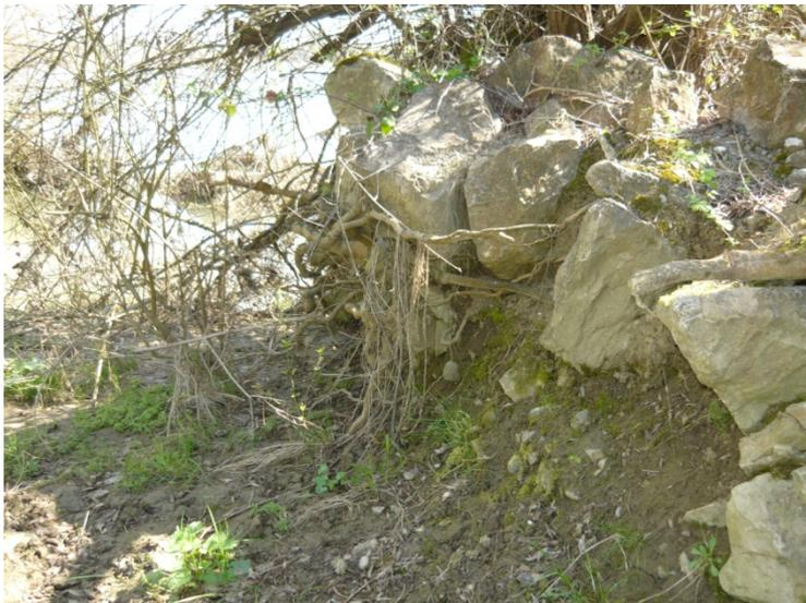
*Erosion de berge en aval immédiat d'un épi submersible en crue*
