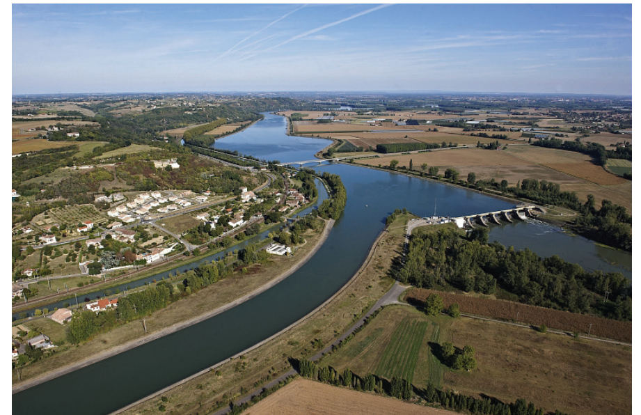
Le barrage de Malause redirige les eaux de la Garonne vers les centrales électriques
