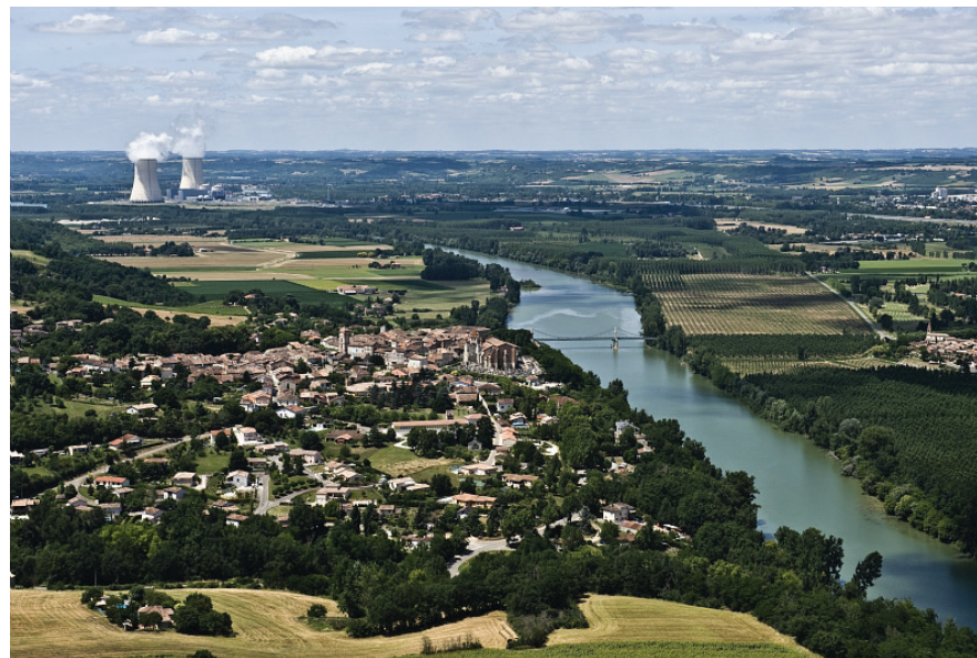
Vue sur l'ensemble du territoire depuis l'est, Avillar domine la vallée, les tours aéroréfrigérantes dominent le paysage
