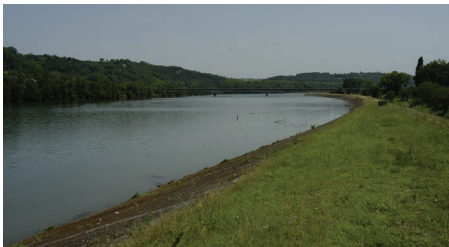
Le canal de Golfech captant une grande partie du débit du fleuve
