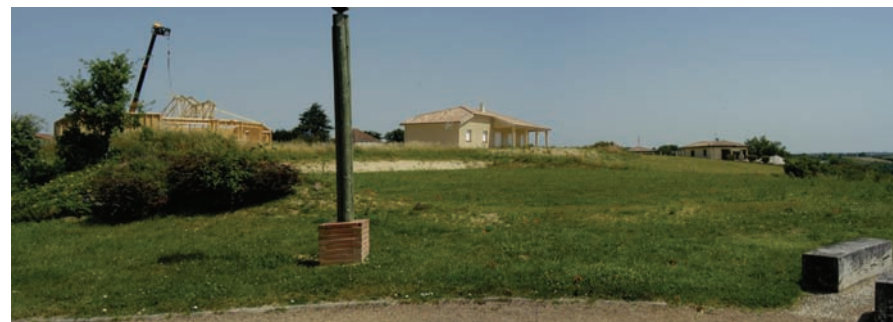
Nouvelles constructions sur le coteau à Boudou
