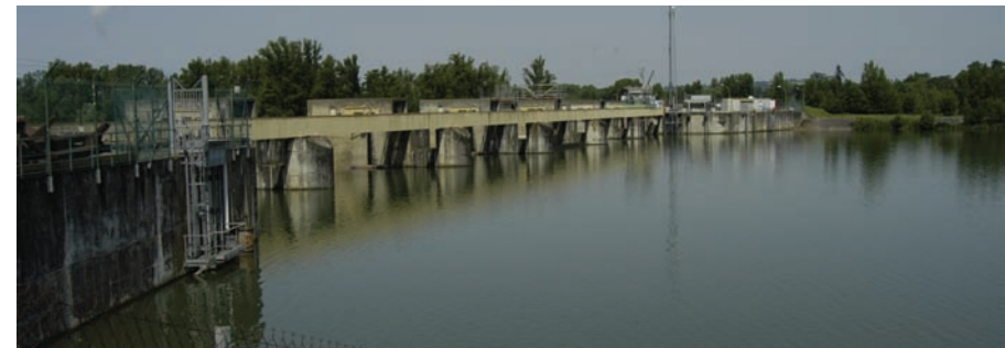
Le barrage de Malause, qui a permis la montée du niveau des eaux
