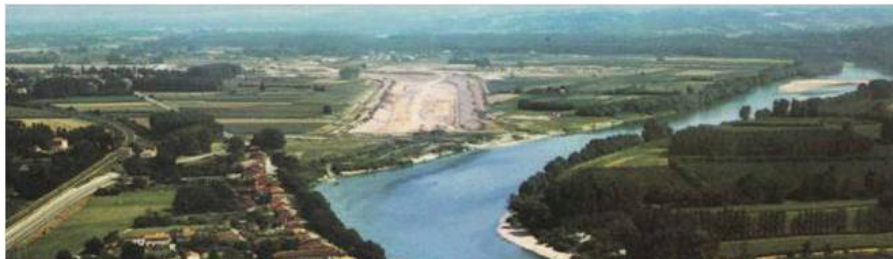
Le canal de Golfech en cours de creusement
