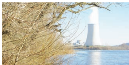
La centrale nucléaire depuis Lamagistère en aval
