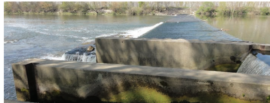
Seuil équipé d'une passe à poissons sur Espalais
