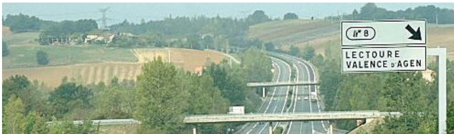
L'A62, la dernière grande infrastructure construite
