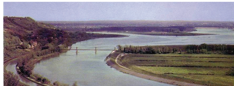
La confluence du Tarn après la mise en place du barrage
