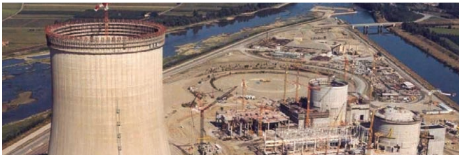
La centrale en construction
