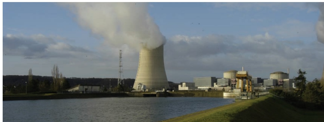
La centrale, un point de vue inédit sur le patrimoine industriel à valoriser
