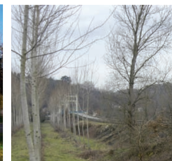
L'accès au pont d'Auvillar
