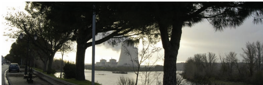
La centrale vue depuis les quais de Lamagistère
