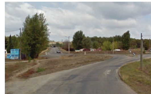
Le carrefour à sécuriser
