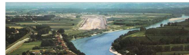
La construction du canal de Golfch
