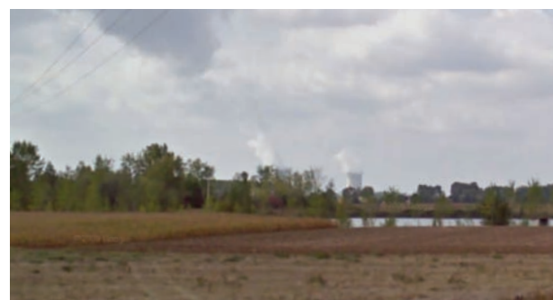
Les cheminées de la centrale de Golfech
