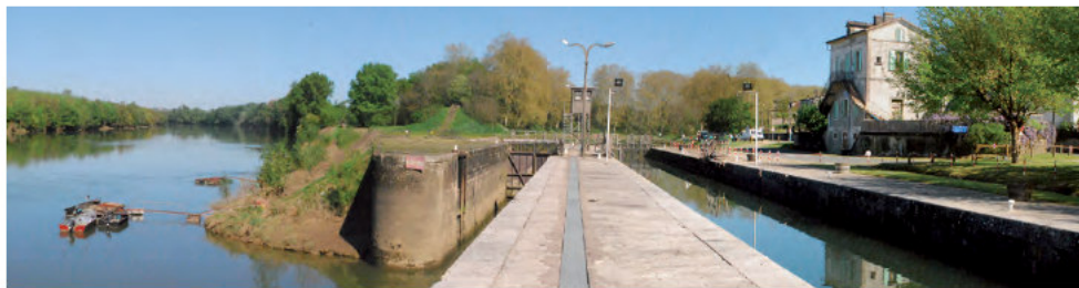
L'écluse majestueuse de Castets-en-Dorthe, à la confluence entre canal et Garonne
