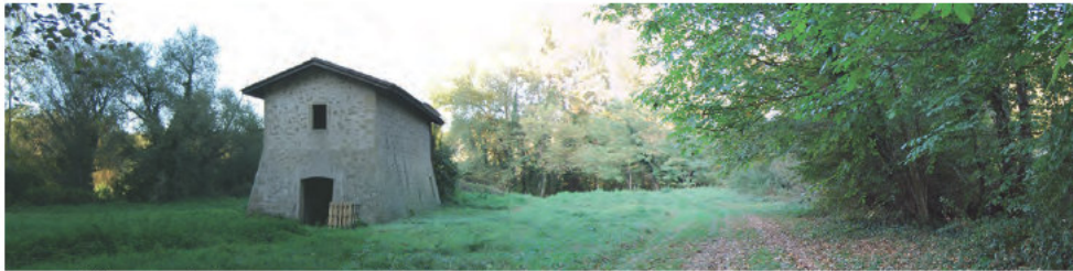
Le magasin de l'éclusier et ses abords composent un site très agréable, mais trop discret et peu accessible
