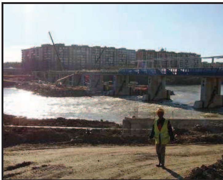
Fig. 4. Travaux pour le nouveau barrage sur l'Ebre dans la ville de Saragosse
