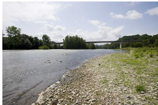
Banc de galets en aval du pont de Bourret (82)
