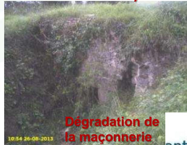
**Dégradation de la maçonnerie support (vieillessement)**
