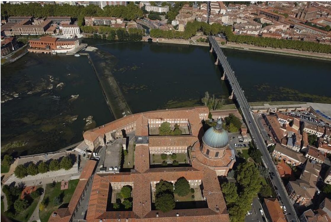
Vue aérienne de l'Hôpital de la Grave en rive gauche de la Garonne à Toulouse (D. Taillefer)
