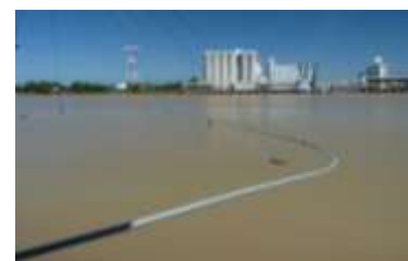
Centrale thermique au Bec d'Ambès - T.PICHILLOU-BIOTOPE © (photo prise sur site)
