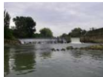
Barrage et écluse de la Baïse - N.LEGRAND -BIOTOPE ® (photo prise sur site)
