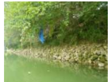
Enrochements sur berges - T.PICHILLOU-BIOTOPE © (photo prise sur site)
