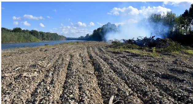
Fin de la phase 1 avec scarification de l'atterrissement et brulage sur site des souches
