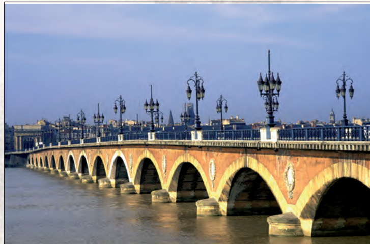
Le pont de Pierre construit en 1821, premier ouvrage permettant le franchissement de la Garonne. Source Internet : www.google.fr (rubrique google images)
