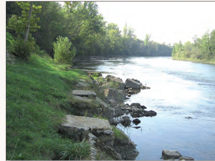
Les maçonneries des quais sombrent dans la rivière et s'apparentent à des rochers. Les rampes recouvertes d'herbe se devinent à peine. Une impression d'abandon émane de la berge (Marquefave).
