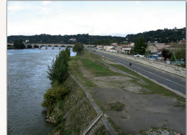
appel L'implantation de la ville d'Agen dans le lit majeur de la Garonne a nécessité l'aménagement d'un grand nombre d'ouvrages de fixation du lit contre les inondations.
