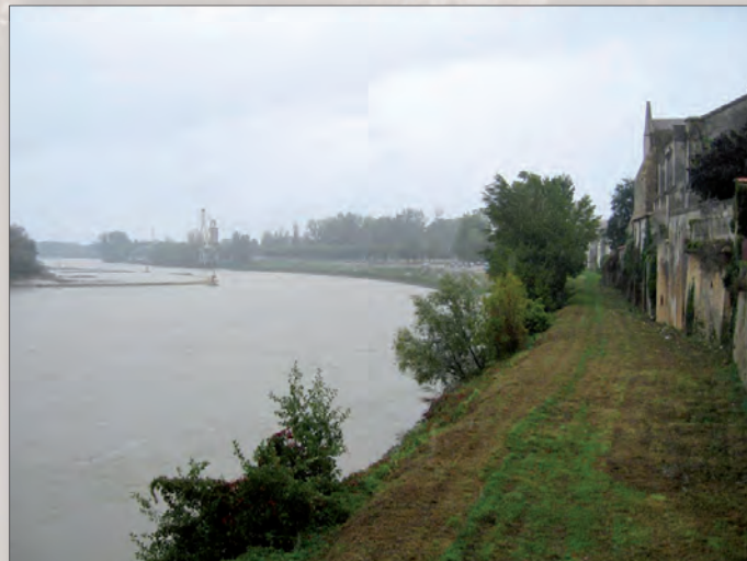
Langon a conservé ses activités portuaires et accueille les barges de l'A380 pour le transfert de charge sur route. A l'instar des ports, son front bâti opacifie le paysage fluvial.
