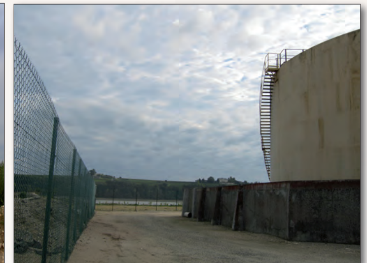
Le paysage est emprunt de contrastes, en premier plan les conteneurs de pétrole, au second plan les coteaux de Bourg, leur végétation dense et leurs châteaux.
