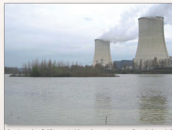
Les tours de refroidissement et les colonnes de vapeur d'eau de la centrale nucléaire de Golfech constituent des points d'appel très forts, perceptibles des premiers sommets des Pyrénées.
