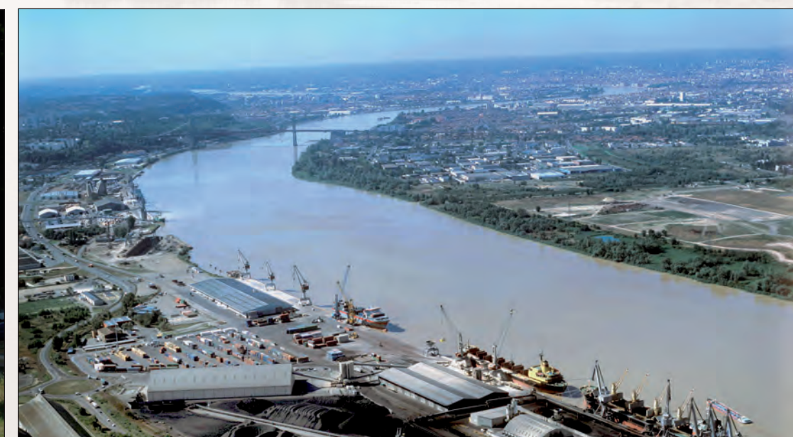
A l'aval de Bordeaux, la zone industrielle de Bassens s'est implantée sur les terrains plats marécageux qui bordent la ville. La silhouette et le gigantisme de ces installations marquent fortement le paysage.
