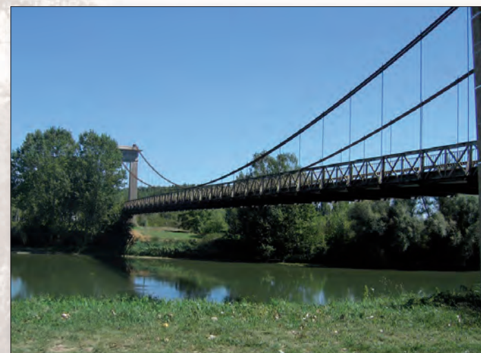
Les ponts suspendus sont lancés au dessus de la rivière la laissant libre de tout appui. La sensation de saut est accentuée par le rythme et la finesse des câbles et par la courbe tendue du tablier au dessus de l'eau (Verdun-sur-Garonne).
